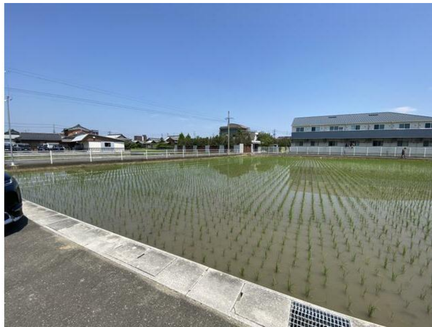
造成工事完了後のお引渡し☆
