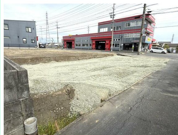
造成工事・上下水道引込工事完了済！
