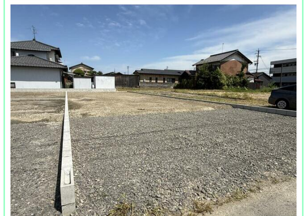
造成工事・上水道引込工事完了済☆
