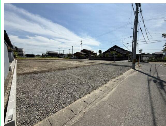
造成工事・水道引込工事完了済☆
