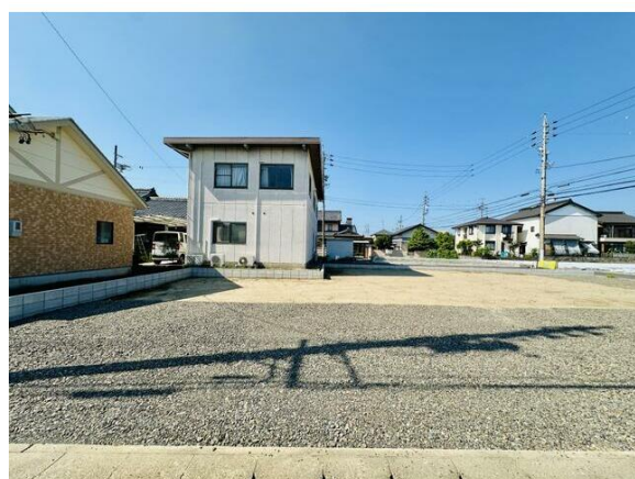
造成工事完了済！
