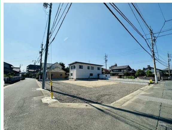
造成工事・上下水道引込工事完了済！
