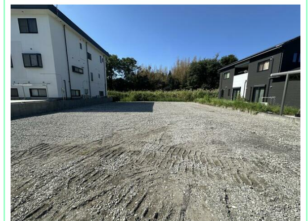
造成工事完了済みです☆
