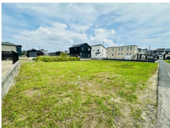
造成工事・上下水道工事完了後にお引渡し☆
